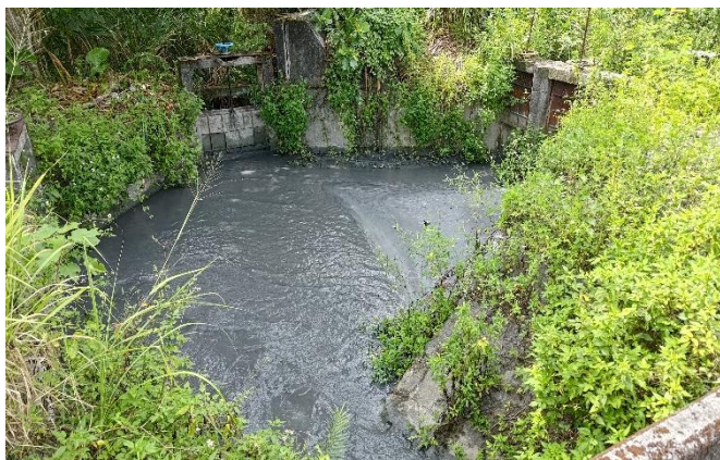
穿越線 e 溝渠
