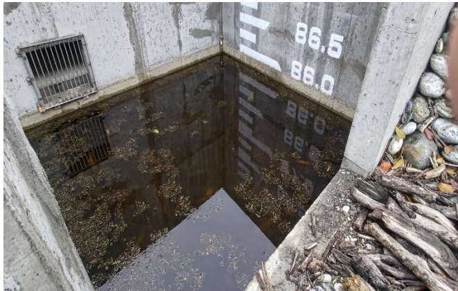
穿越線 a 滯洪池排水口水池
