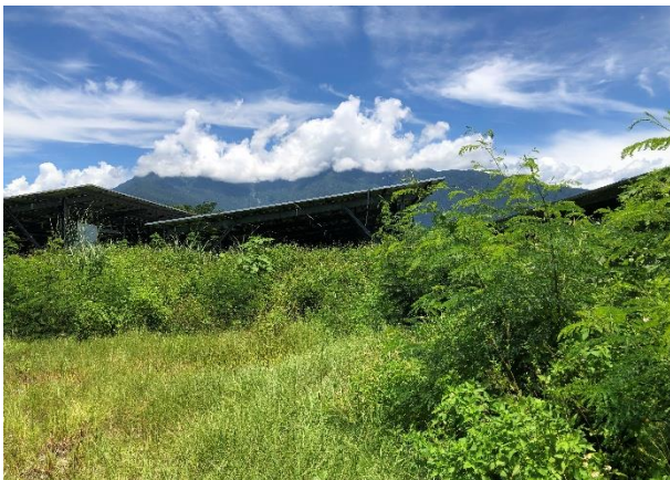
圖 16 南端西側單元變電站周邊環境照片
