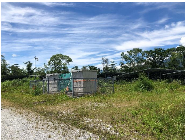
圖 14 南端西側單元變電站周邊環境照片
