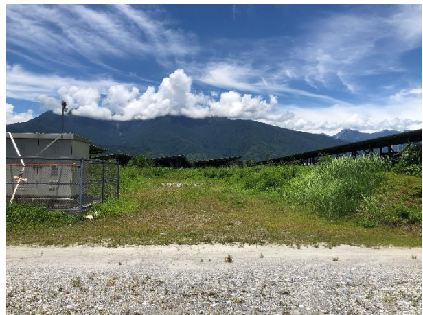
圖 21 北端西側單元變電站周邊環境照片
