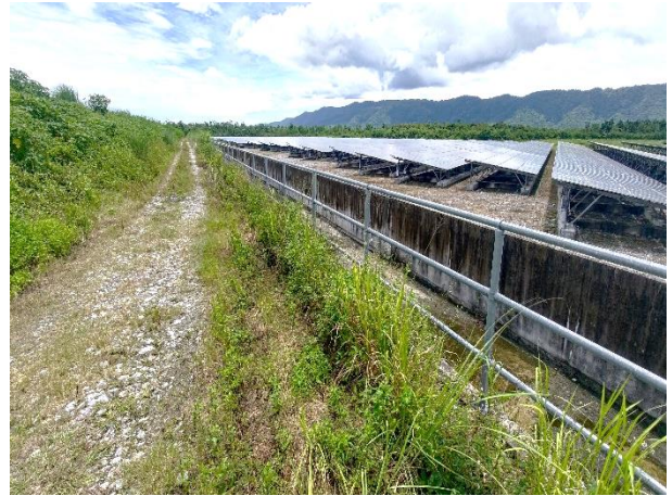
圖 13 排水道欄杆現況照片
