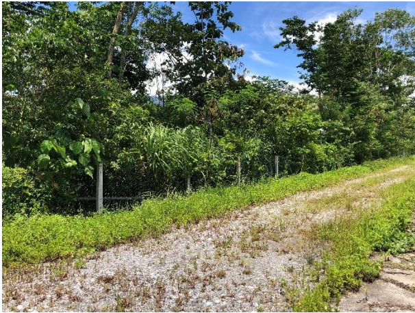
圖 12 廠區外圍圍籬現況照片(鐵絲網)
