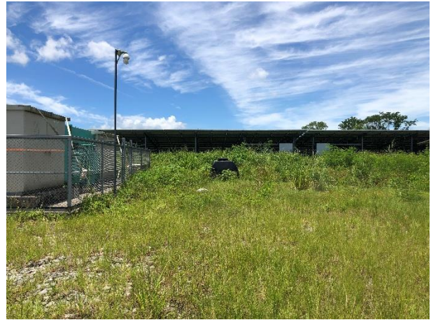
圖 19 北端西側單元變電站周邊環境照片
