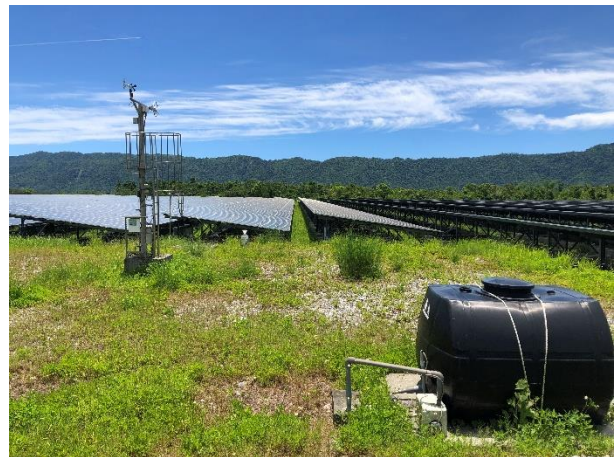
圖 23 北端東側單元變電站周邊環境照片
