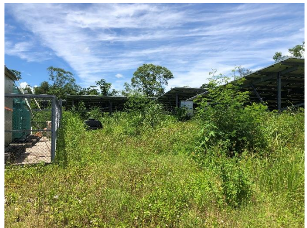
圖 15 南端西側單元變電站周邊環境照片
