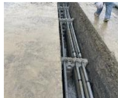
STEP 3 管路埋設
