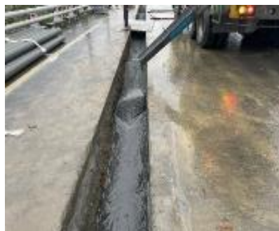
STEP 4 混凝土澆置
